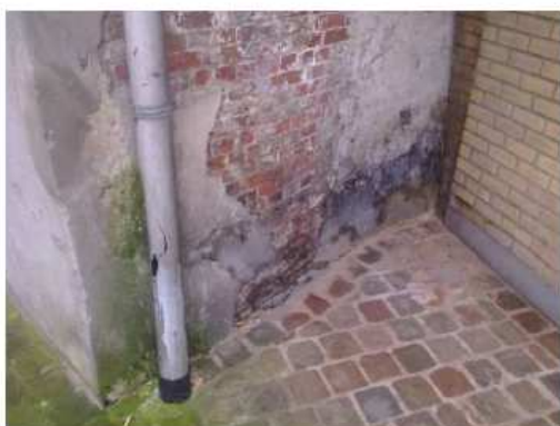
rue du Magasin 32- avant
